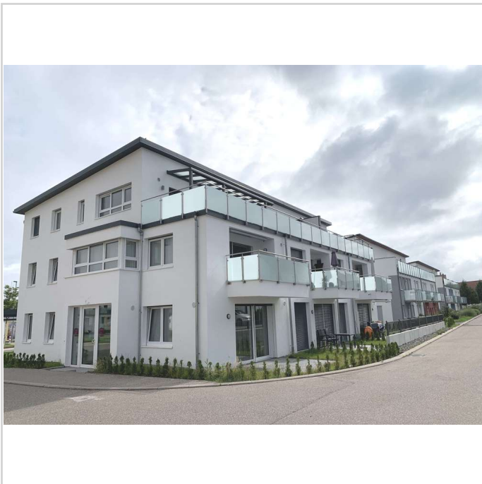
Hausansicht mit Balkon
