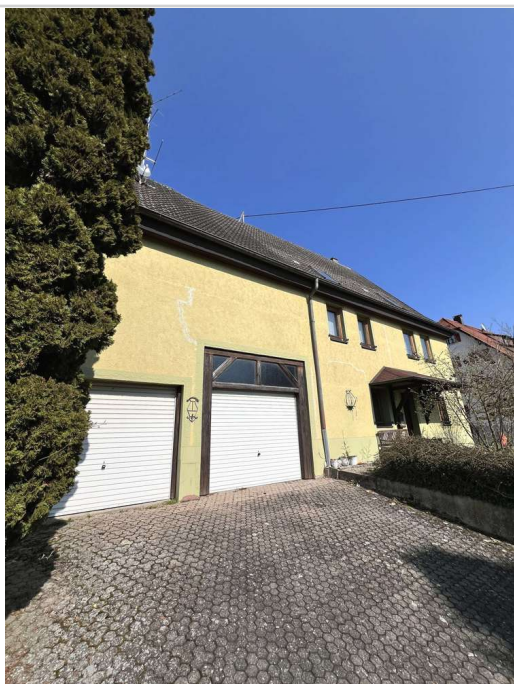
Hausansicht mit Scheune/Garage
